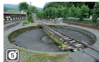
▲千頭駅構内の転車台 イギリス製で東赤谷駅(新潟県新発田市)から1980年7月に移設されました。手動式で駅員や機関士の5人がかりでSLを方向転換させます。登録有形文化財(建造物)に指定されています。
