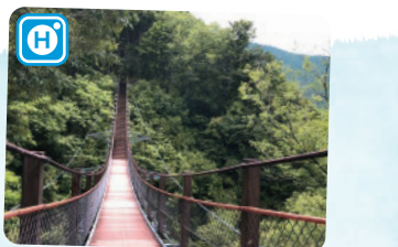
八橋小道(宮沢橋) 接岨峡に架かる8つの橋の内の一つ。階段式の吊り橋では日本最長。長さ62m・高さ19m
