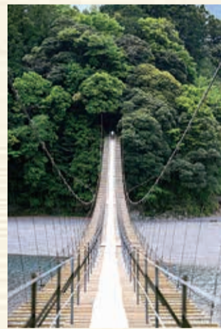
塩郷の吊り橋(恋金橋) ●Shioigo Suspension Bridge (Koikane Bridge) 大井川に架かる一番長い吊橋で、長さは220.4m。大井川の広大さを実感できるスポットです。 SLが吊り橋の下を通ります。 This is the longest suspension bridge spanning the Oigawa River.
