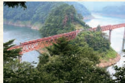
レインボーブリッジと奥大井湖上駅 ●Rainbow Bridge to Okuooi Kojo Station レインボーブリッジと、湖中央の突き出た山に置かれた湖上駅からは、接岨峡随一の美しい自然の大パノラマが楽しめます。湖上駅には、コテージ風の休憩棟があり、自然の息吹を味わうことができます。 Sitting in the middle of a bridge atop a dam, Okuooi Kojo Station was chosen one of the best 100 train stations in central Japan. There is a path to Sessokyo Hot Spring where you can enjoy walking above the lake.
